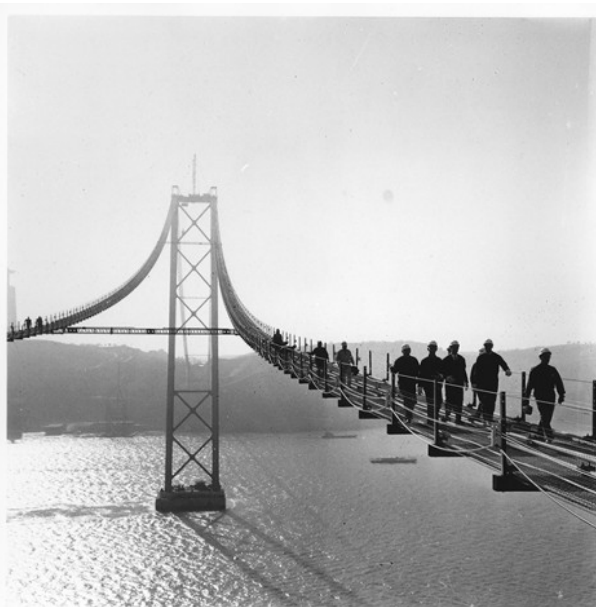
Ponte em construção
