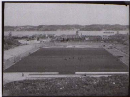
[Estádio do Restelo em construção]. S/ data. JOVR/Cont7, cx1, neg1
