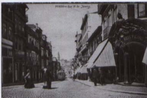
Rua 31 de Janeiro. Porto. S/ data. CBP001
