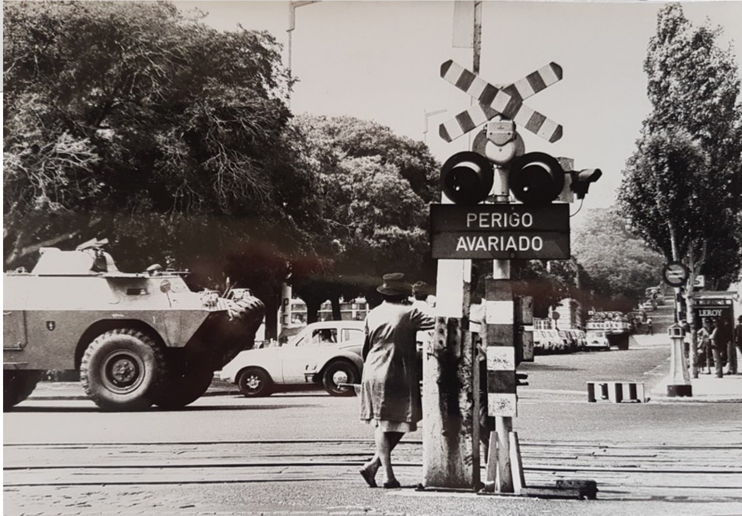
“Perigo. Avariado”. Portugal, Torre do Tombo, Flama, Positivos, Comboios, pt. n.º 1448, n.º 45
