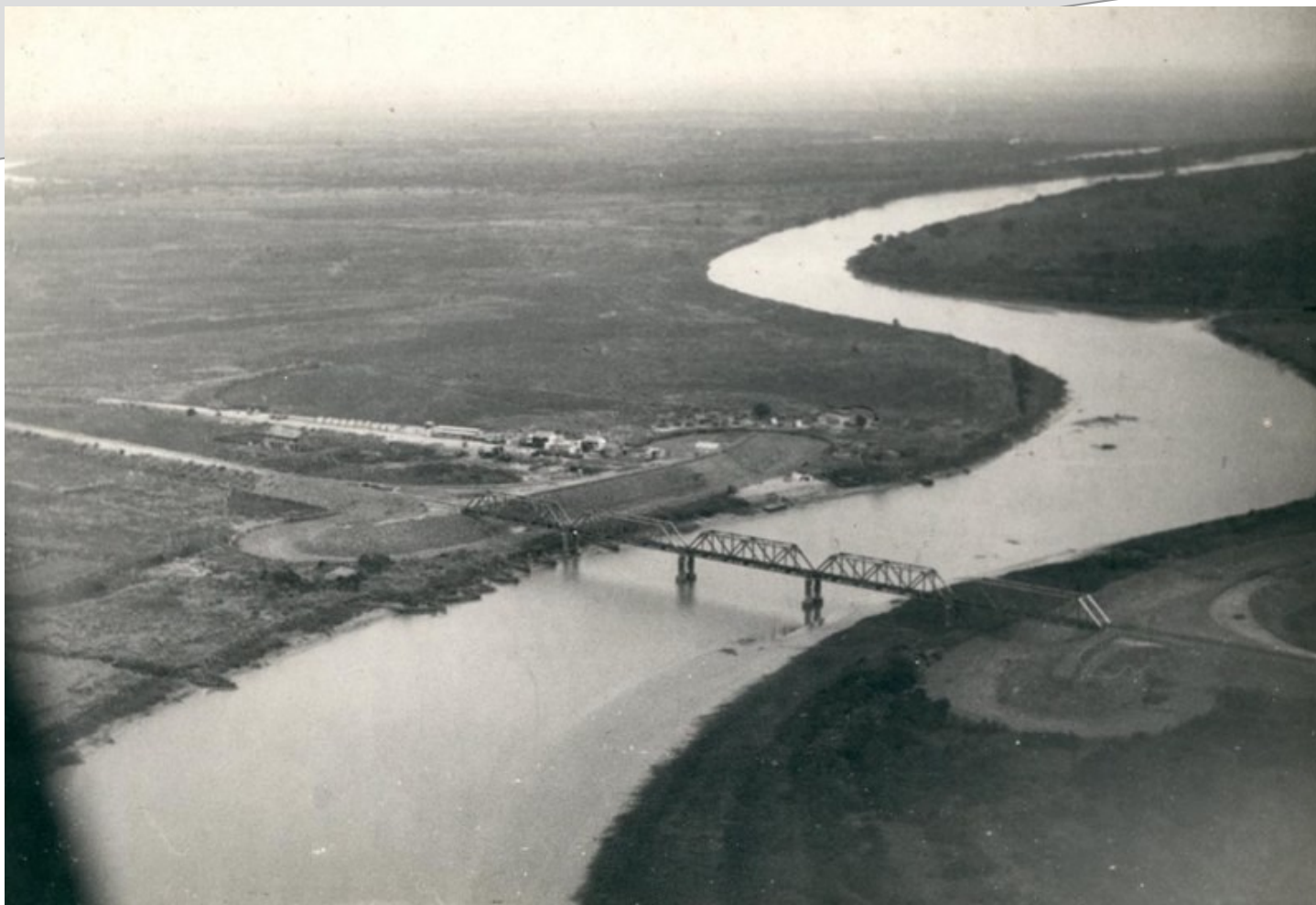
"Caminho de ferro da Beira à Rhodesia". [193-]. Vista aérea da ponte metálica do Pungué, com cerca de 250 m de extensão, considerada uma das mais importantes obras construída na década de trinta. Portugal, Torre do Tombo, Companhia de Moçambique, cp. n.º 5, n.º de ordem 3029, n.º 8.
